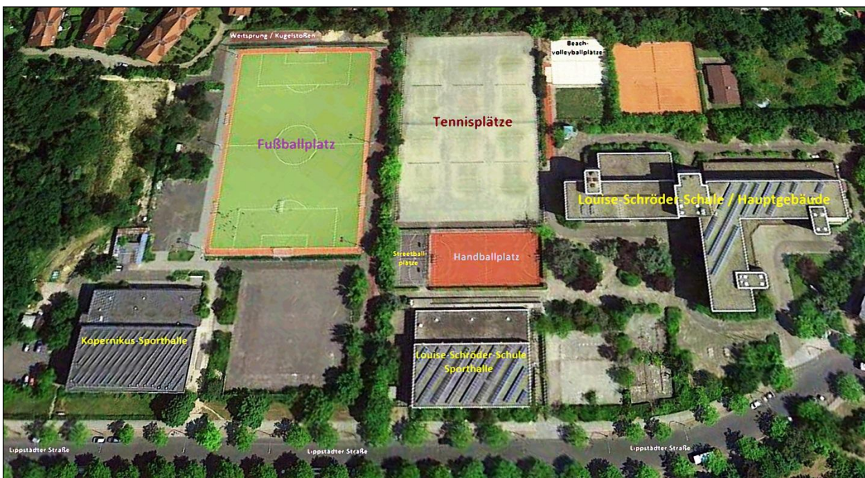
(Louise-Schroeder-Schule, Lippstädter Straße 9 - 11, 12207 Berlin, Schulgelände und Sportanlagen)
